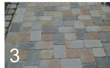
Fläche rückstandsfrei abkehren und dabei abgepacktes Material auffüllen, bei rauer Steinoberfläche z. B. mit Laubbläser Materialreste entfernen.
