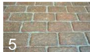
**POLYSAND** muss vollständig durchtrocknen um optimal abzubinden.
