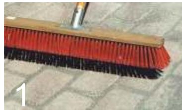
**POLYSAND** auf der trockenen Pflasterfläche verteilen und in die Fugen einkehren.
