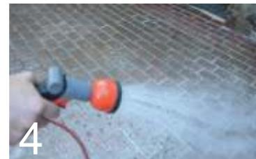
Kleinflächig arbeiten (10 -20 qm) zweimal im Abstand von 5 Minuten benetzen bis die Fuge gesättigt ist, dabei direkten Wasserstrahl auf die Fuge vermeiden. Stehendes Wasser entfernen (Laubbläser).
